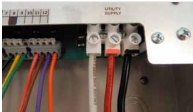
4. 商用電源の電圧が正しく、ATSの定格に適合している必要があります。
